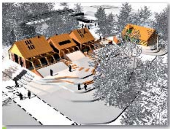
Ryc. 2. Zespół zabudowy na „Dziewiczej Górze” Fig. 2. Building complex in “Dziewicza Góra”
