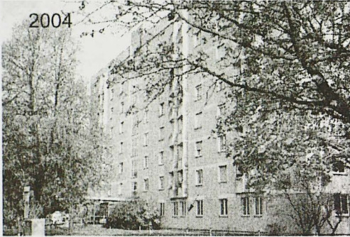
Rys. 6. Zachodnia fasada obiektu 16 (dom starców w Monachium) we wrześniu 1989 r., trzy lata po zastosowaniu systemu ETICS oraz 15 lat później w listopadzie 2004 r. (różnica koloru nie oznacza, że fasada została pomalowana, jest to raczej problem koloru w fotografii cyfrowej). Formacje alg wyraźnie widoczne w miejscach bardziej wystawionych na działanie deszczu (zob. strzałkę oraz por. rys. 7)
