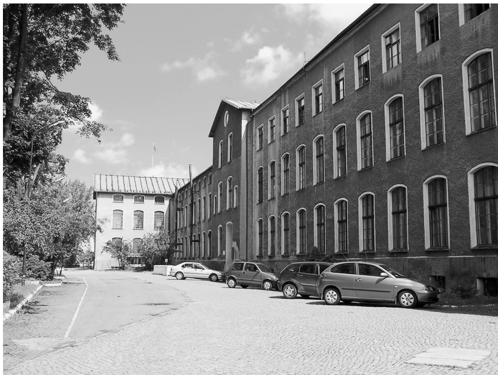
Fot. 2. Głuszycza. Widok na tkalnię (fot. J. Gubański) Phot. 2. Głuszycza. The view of the weaving mill
