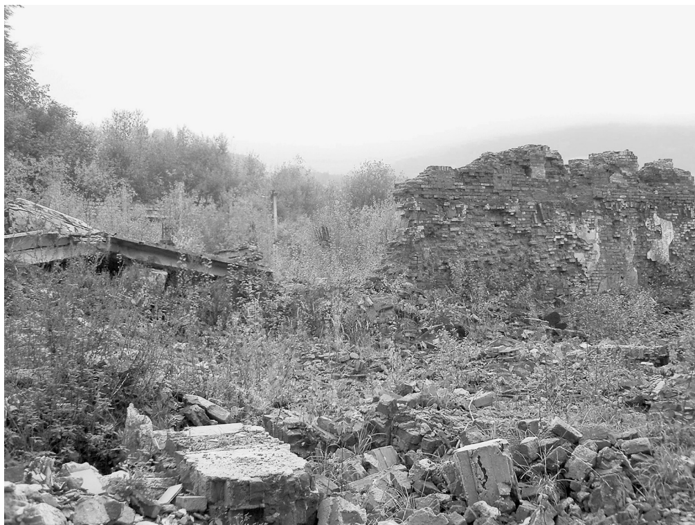
Fot. 5. Walim. Obecny widok na dawną fabrykę włókienniczą (fot. R. Gubańska) Phot. 5. Walim. The actually view of the old factory of the textile industry
