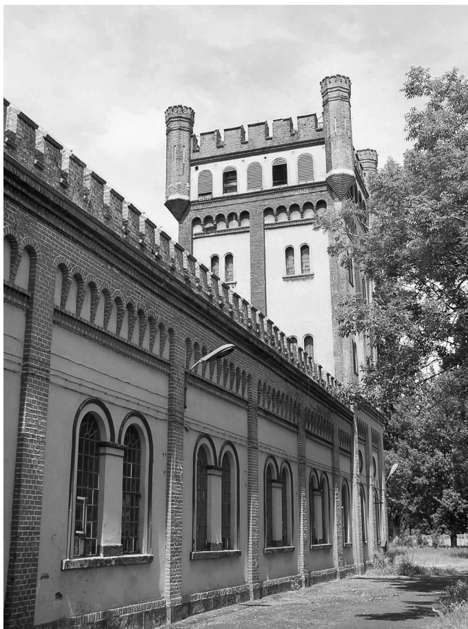
Fot. 1. Prudnik. Widok na tkalnię starą, w tle wieża ciśień (fot. R. Gubańska) Phot. 1. Prudnik. The view of the old weaving mill, in the background – the water tower
