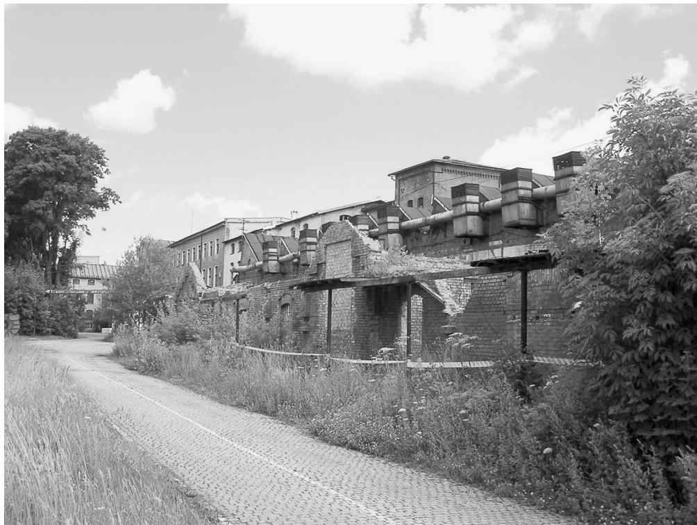
Fot. 3. Głuszycza. Przykład zniszczonej hali produkcyjnej (fot. R. Gubańska)
