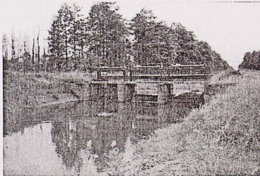
Rys. 5. Jaz z mostem w Nowej Dąbrowie na kanale Lasica – widok od strony wody górnej (fot. A. Włodarczyk)
