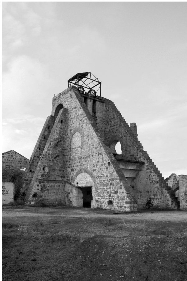
Fot. 5. Kamienna wieża wyciągowa. Linares (Hiszpania) (fot. autor) Phot. 5. Stony winding tower. Linares (Spain)
