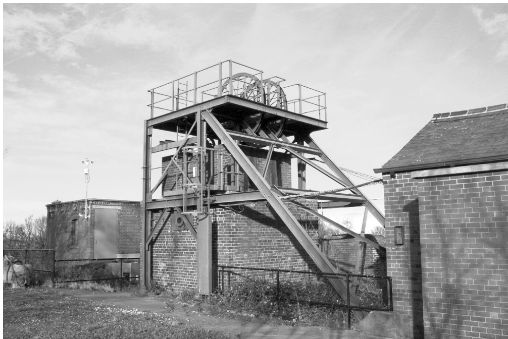
Fot. 3. Wieża maszyny wyciągowej. Caphouse (Anglia) (fot. autor) Phot. 3. The head-frame of the winding shaft. Caphouse (England)
