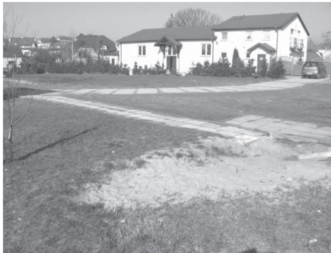
RYSUNEK 1. Miejsce posadowienia budowli FIGURE 1. View of structures site
