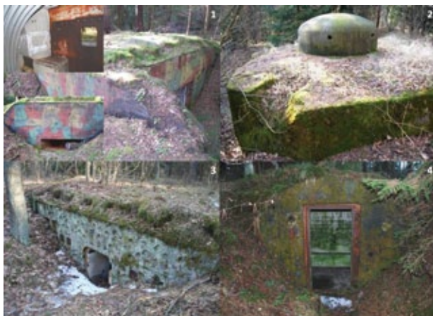
Ryc. 3. Przykłady schronów: 1 – bojowy (o odporności B1), 2 – obserwacyjny (z kopułą), 3 – dowodzenia (dowódcy batalionu), 4 – bierny (np. ukrycia piechoty) (fot. W. Ostrowski)
