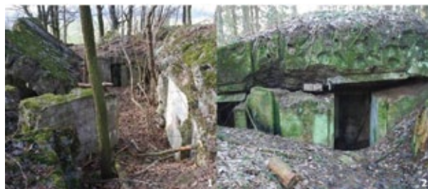
Ryc. 4. Schrony bojowe: 1 – zniszczony (wysadzony); 2 – uszkodzony (eksplozja nie zmieniła zasadniczo kształtu obiektu)
