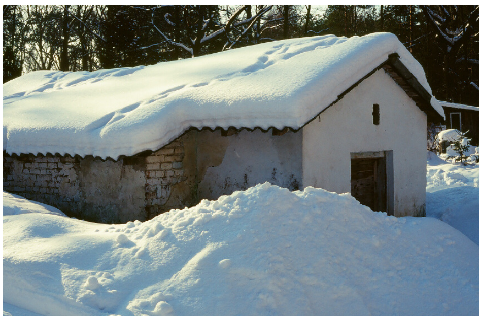
Fot. 1. Piwnica w Pogorzeli Warszawskiej, 13 II 2009 (fot. G. Lesiński)
