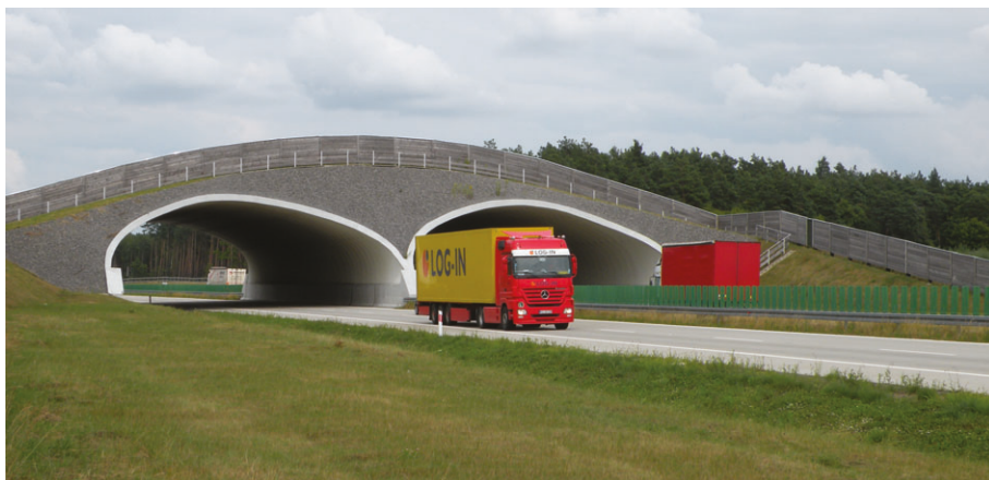
Fot. 1. Górne przejście dla zwierząt na autostradzie A4 (odcinek Zgorzelec-Krzyżowa) (fot. R.W. Mysłajek)
