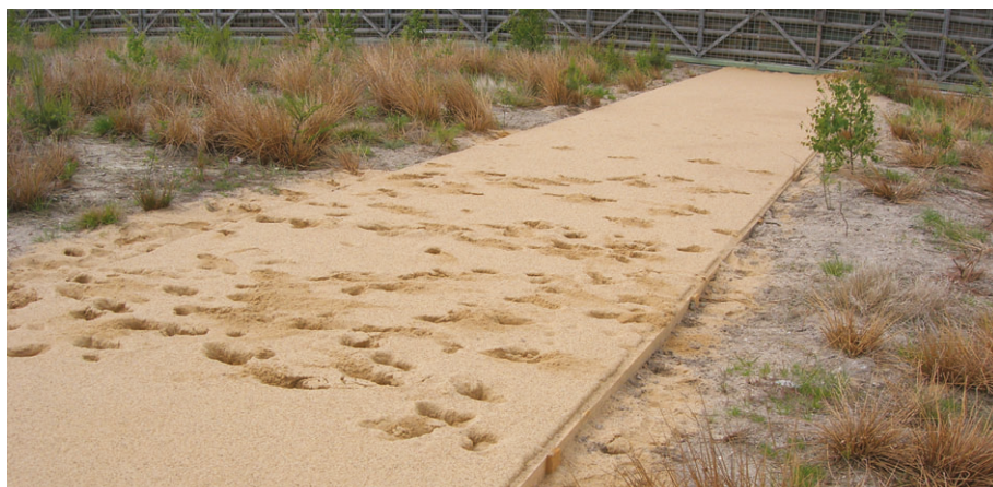
Fot. 3. Tropy jeleni na pasie z piaskiem służącym do monitoringu na górnym przejściu dla zwierząt na autostradzie A4 (odcinek Zgorzelec-Krzyżowa) (fot. R.W. Mysłajek)
