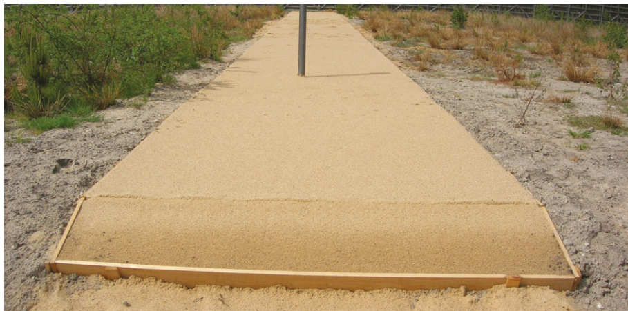
Fot. 2. Pas z piaskiem służący do monitoringu zwierząt na górnym przejściu dla zwierząt na autostradzie A4 (odcinek Zgorzelec-Krzyżowa) (fot. R.W. Mysłajek)
