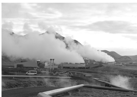
Ilustracja 1. Islandia – Hellisheiði, największa na świecie elektrownia geotermalna. Fot. „EkoLubelszczyzna”
