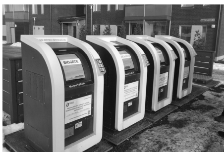
Ilustracja 9. Finlandia, Tampere – pneumatyczne „kosze na śmieci”. Odpowiednio posortowane odpady są w nich zasysane przez system rurociągów do oddalonych nawet o 4 km punktów utylizacji. Fot. „EkoLubelszczyzna”
