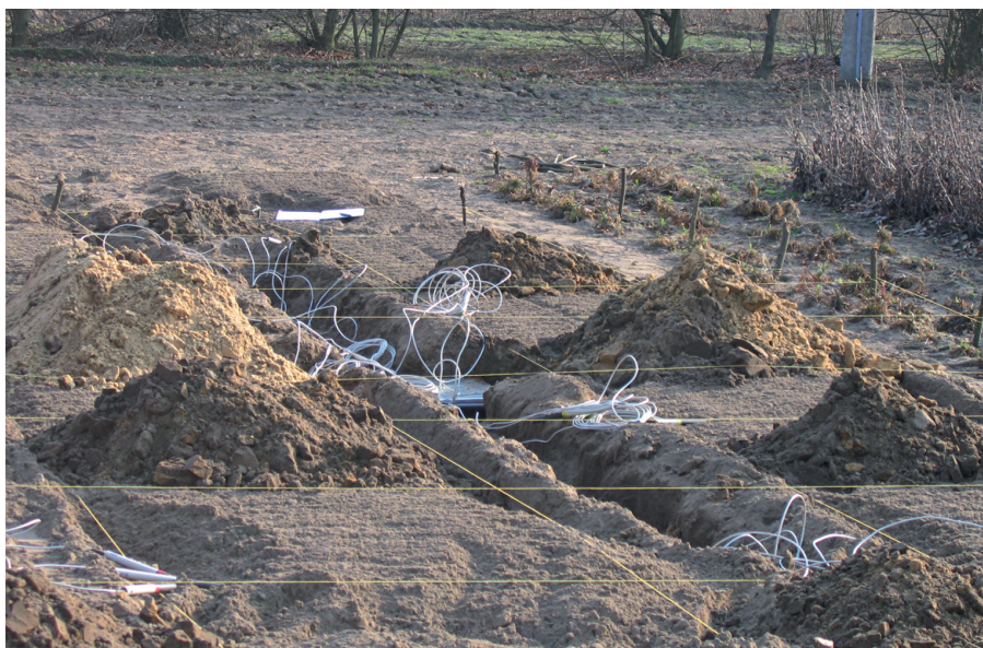
Fot. 1. Polowy system monitorowania parametrów fizykochemicznych gleb w trakcie instalacji Photo 1. Field monitoring system of physico-chemical soil parameters during installation
