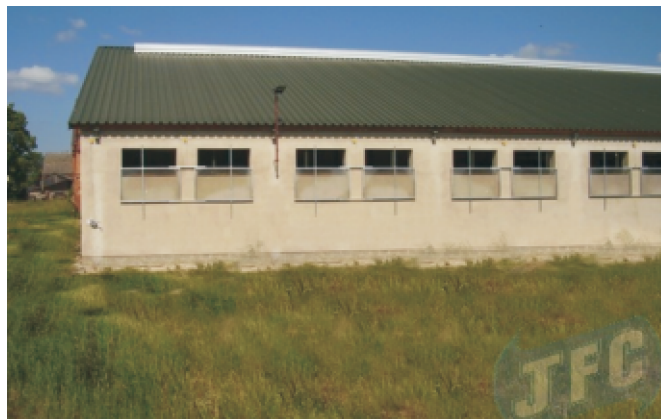
Rys. 3. Przesuwne okna wentylacyjne z poliwęglanu produkcji JFC POLSKA Sp. z o.o., Dąbrówka, Polska
