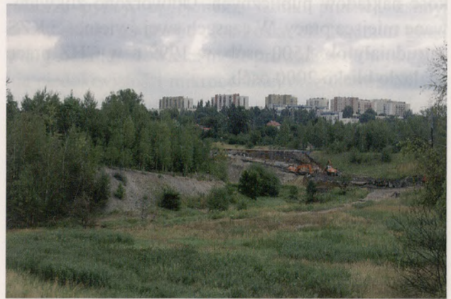
Ryc. 5. Budowa drogi dojazdowej. Fot. Mateusz Okrutniak
