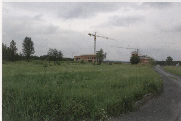
Ryc. 4. Plac budowy. Fot. Mateusz Okrutniak
