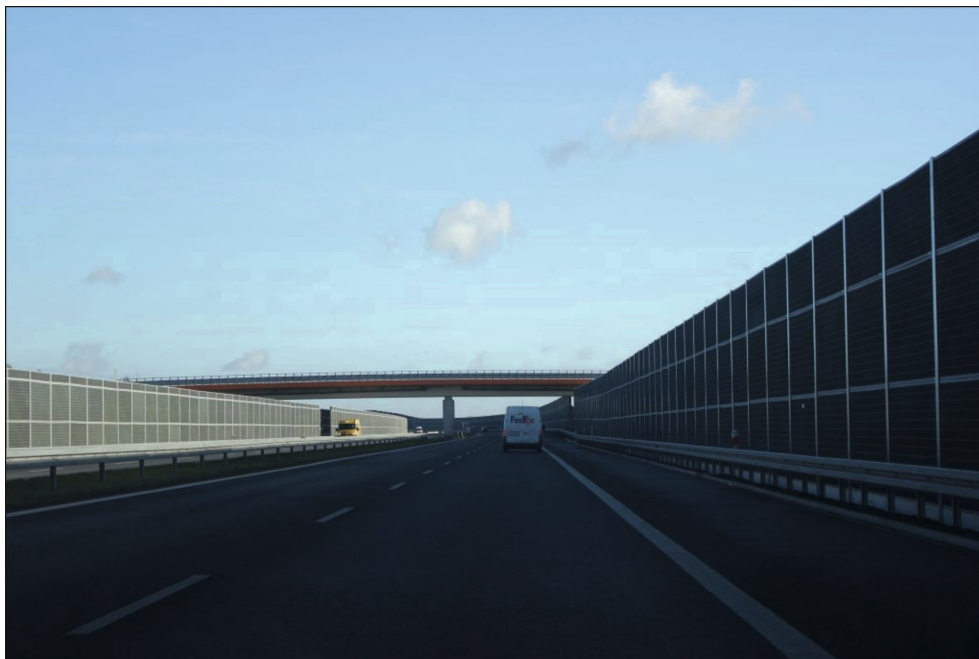
Ryc. 6. Ekrany akustyczne na autostradzie A4 w województwie małopolskim (fot. M. Jakiel). Fig. 6. Road acoustic screens on the A4 highway in Małopolska voivodeship (fot. M. Jakiel).
