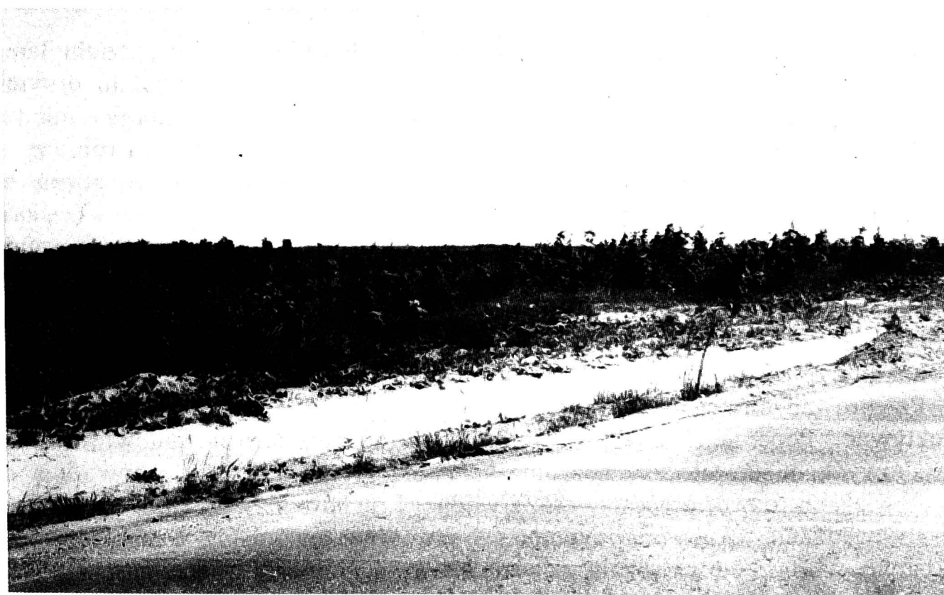
Fot. 3. Zagospodarowanie leśne skarpy zwałowiska wewnętrznego „Pątnów”. Wzdłuż drogi – rów opaskowy, jeden z najważniejszych elementów rekultywacji technicznej
