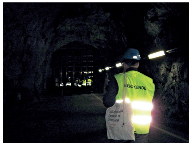
Ryc. 19. Dojście tunelem do hydroelektrowni na rzece Nea.
