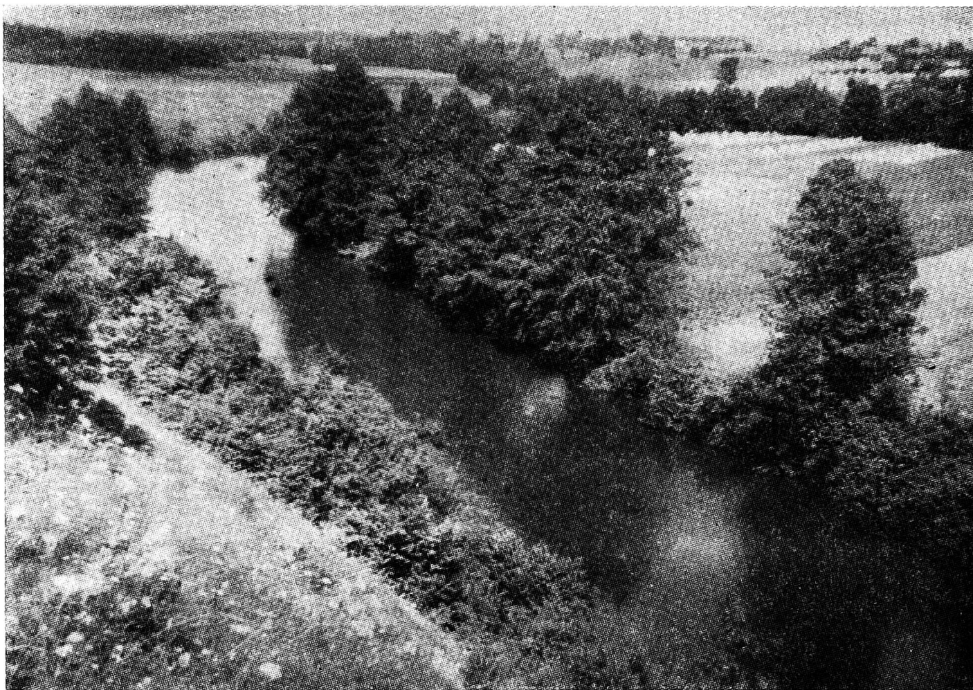
Rys. 6. Umocnienia biologiczne brzegów Wieprza poniżej Łęcznej. Na dnie doliny widoczne pola uprawne. Lato 1965 r.
