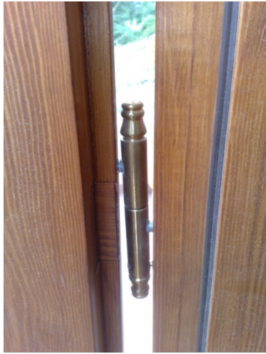
Fig. 4. Improper hinge
