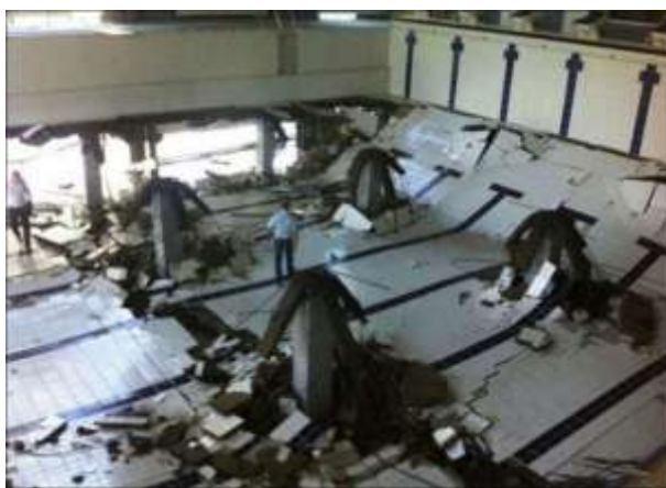
Рис. 1- Результаты разрушения дна бассейна в Краснодаре [1, 15].
