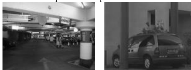
Рис. 4. Строительство подземных и надземных паркингов в опалубке KLILA AMICOTUBE
