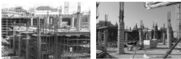
Рис. 5. Возведение монолитных колонн в опалубке из прочного картона при строительстве гостиницы "Москва"
