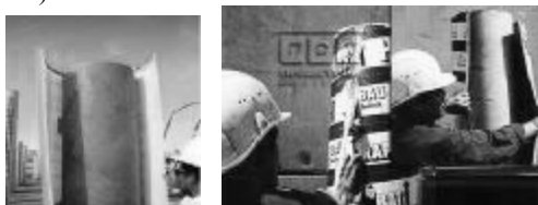
Рис. 10. Демонтаж картонной опалубки
