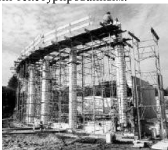
Рис. 3. Возведение монолитных колонн в опалубке KLILA AMICOTUBE
