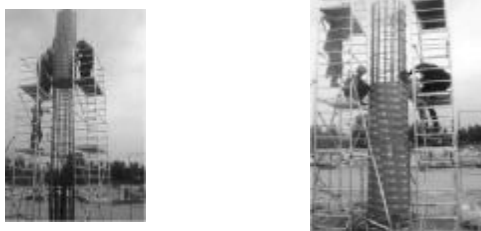
Рис. 11. Установка в проектное положение несъемной опалубки
