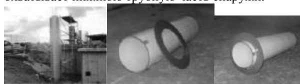
Рис. 8. Временное крепление монолитных колонн в несъемной опалубке в нижней зоне
