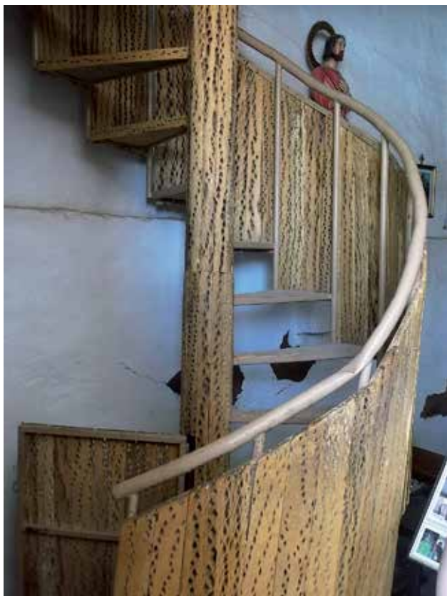
Ryc. 6. Schody wykonane z kaktusowego drewna (fot. Leszek Kucharski, 02 2016).
