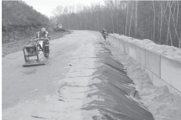
Rys. 2. Budowa muru oporowego Fig. 2. Building of a retaining structure
