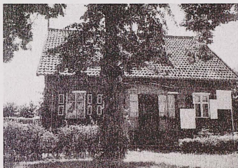
Rys. 4. Drewniany dom mieszkalny z początku XX wieku, Drewnica, Żuławy Wiślane – Warmia. Przykład niewłaściwego docieplenia ścian zewnętrznych za pomocą styropianu, lipiec 2002 (fot. autor)
