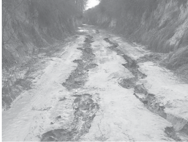
RYSUNEK 2. Erozja żłobinowa dna wąwozu FIGURE 2. Rill erosion in the bottom of road gully
