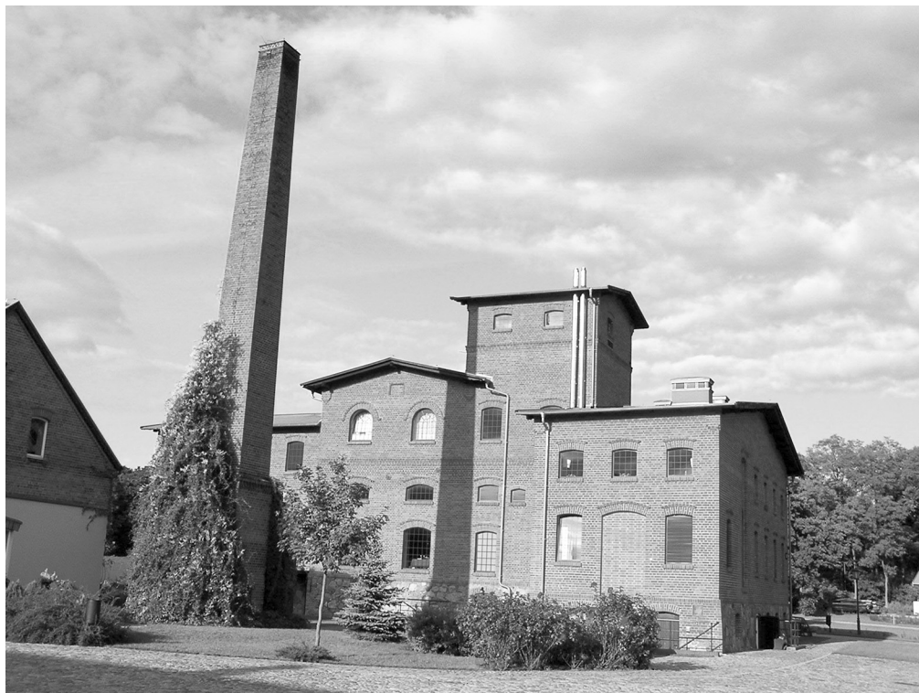
Fot. 3. Gorzelnia w Mierzęcinie (fot. autor) Phot. 3. The distillery in Mierzęcin
