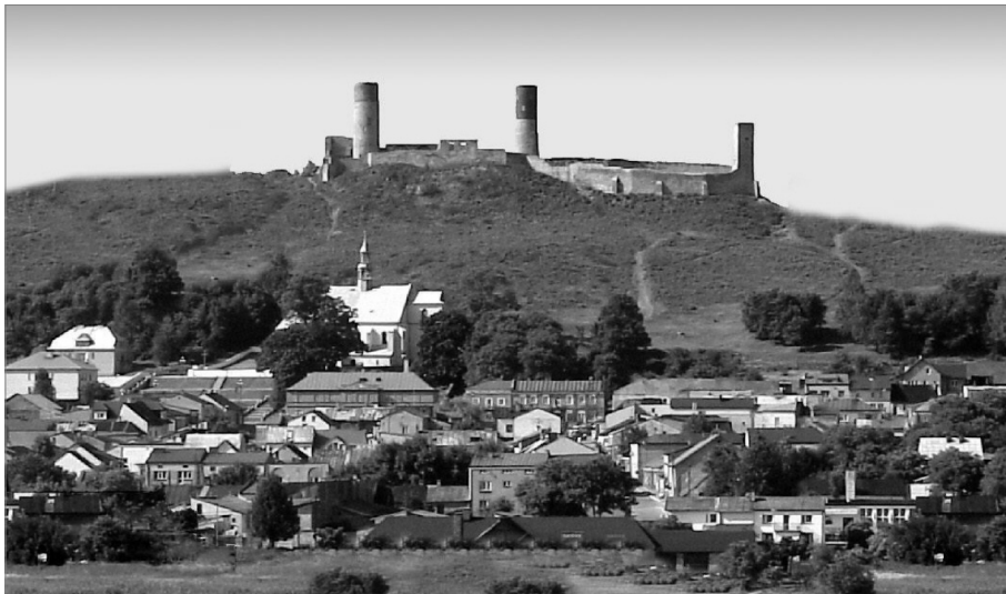
Ryc. 4. Kompozycja fotografii wzgórza zamkowego w Chęcinach z 2003 r. (po odlesieniu środkowej partii) z rekonstrukcją średniowieczną, co daje obraz odlesienia całości południowego skrzydła antykliny chęcińskiej
