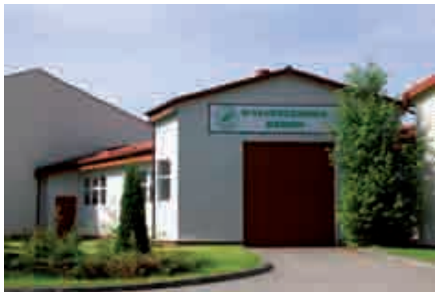
Fot. 6. Budynek nowoczesnej Wyluszcznicy w Nadleśnictwie Czarna Białostocka
