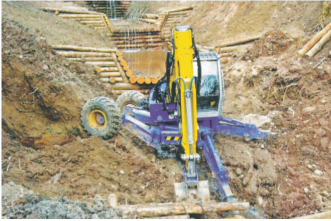
Rys. 3. Maszyna firmy Kaiser podczas pracy przy zabudowie potoku górskiego (fot. firmowa)
