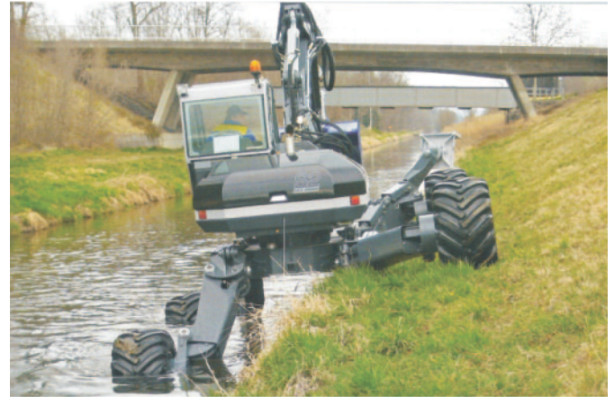
Rys. 4. Maszyna podczas pogłębiania kanału wodnego (fot. firmowa)
