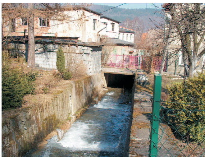
Fot. 2. Obudowa koryta wraz z systemem poboru wody dla dawnego zakładu tkackiego (po lewej stronie) w Pieszycach Górnych
