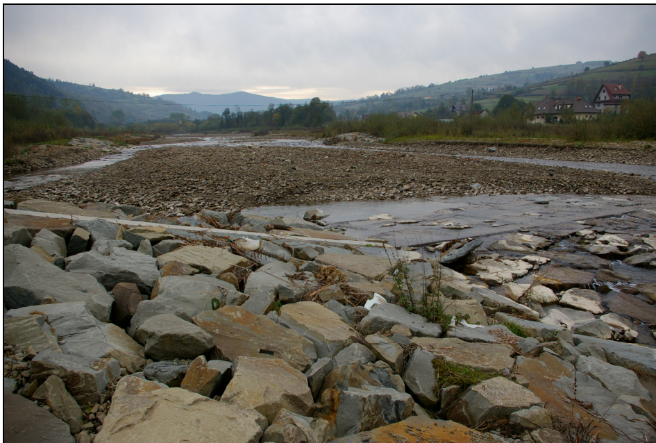
Fotografia 21. Odtwarzająca się łacha korytowa powyżej bystrza o zwiększonej szorstkości (fot. A. Radecki-Pawlik)
