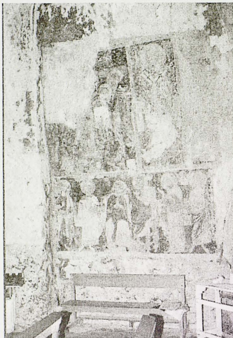
Rys. 8. Zniszczenia dokonane w wapieniu przez glony (Matera, Włochy) Fig. 8. Limestone destruction caused by the alga (Matera, Italy)
