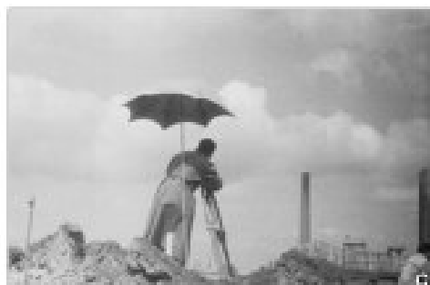
Rysunek 22. Lwów: A, B, C, D – prace przy pomiarze bazy drutami trawersowymi i sieci triangulacyjnej miasta Lwowa. (A – z opaską na rękawie prof. Władysław Wójcicki 1932 r. Fot. I. Rabczuk)
