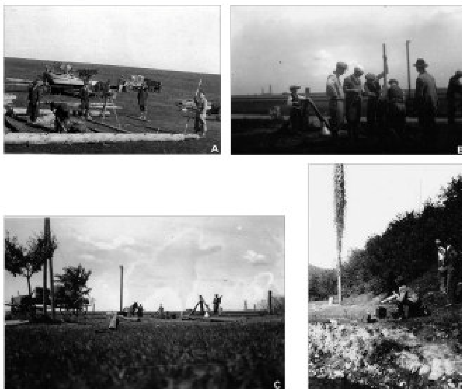
Rysunek 28. Lwowskie. Okolice Drohobycza. A, B, C – fazy budowy wieży wiertniczej, D – wytrysk ropy naftowej. 1935 r. Fot. I. Rabeńk
