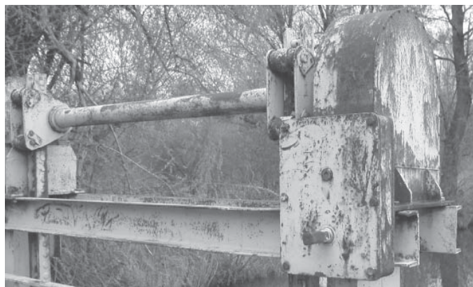
RYSUNEK 7. Mechanizm wyciągowy jazu FIGURE 7. Gate handling equipment of weir
