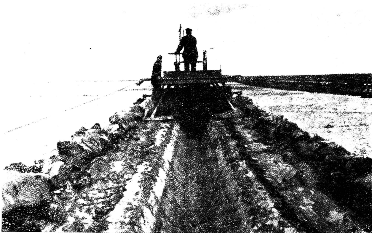
Rys. 6. Kopanie rowów odwadniających na polderze
