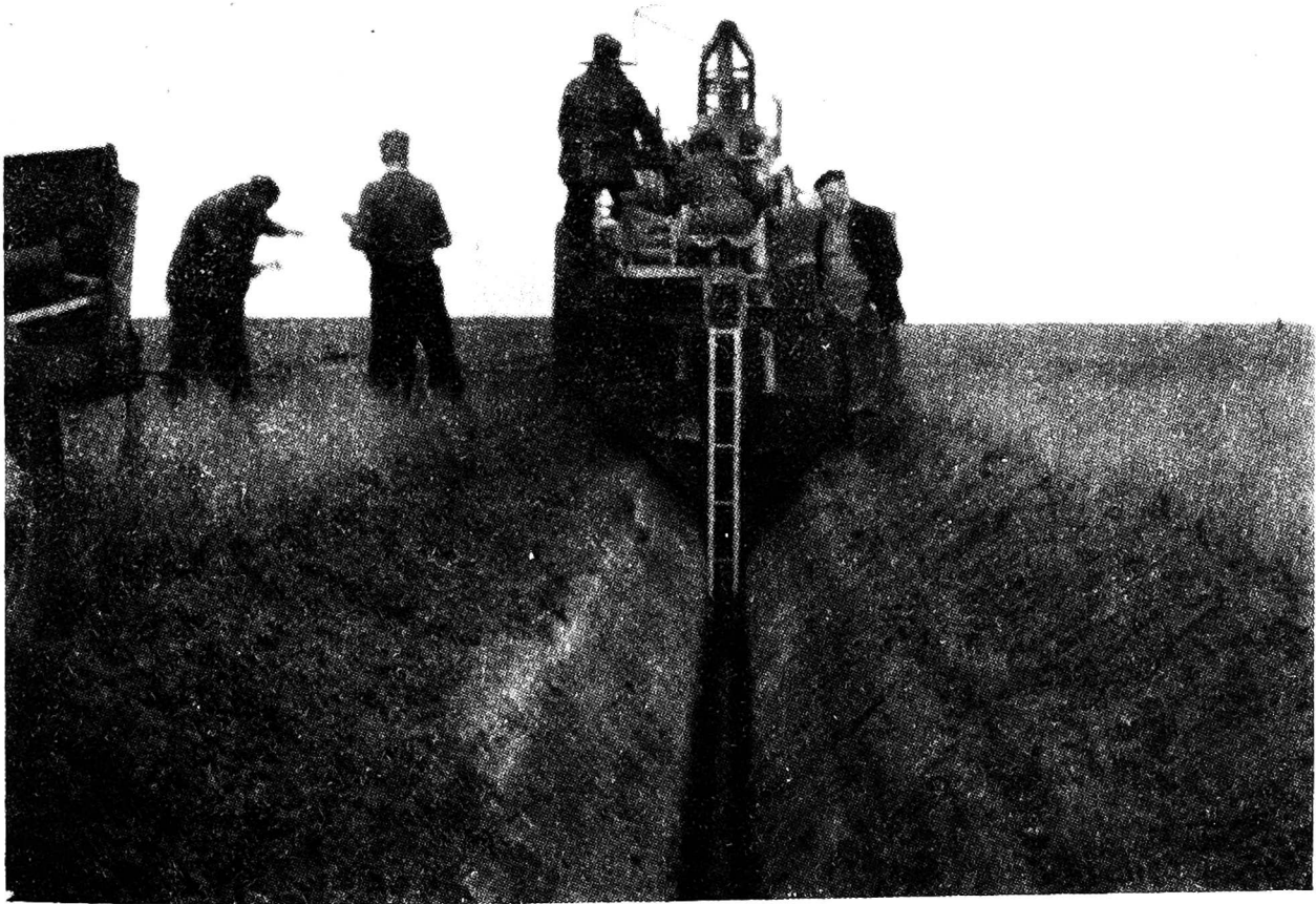
Rys. 8. Układanie sączków na polderze
