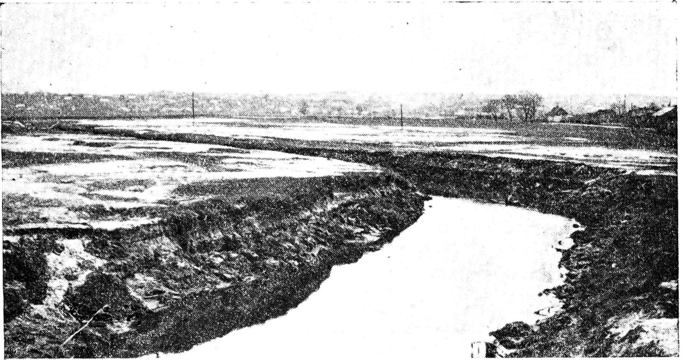
Rys. 11. Zniszczone koryto i namuliska na łąkach po wylewie rzeki
