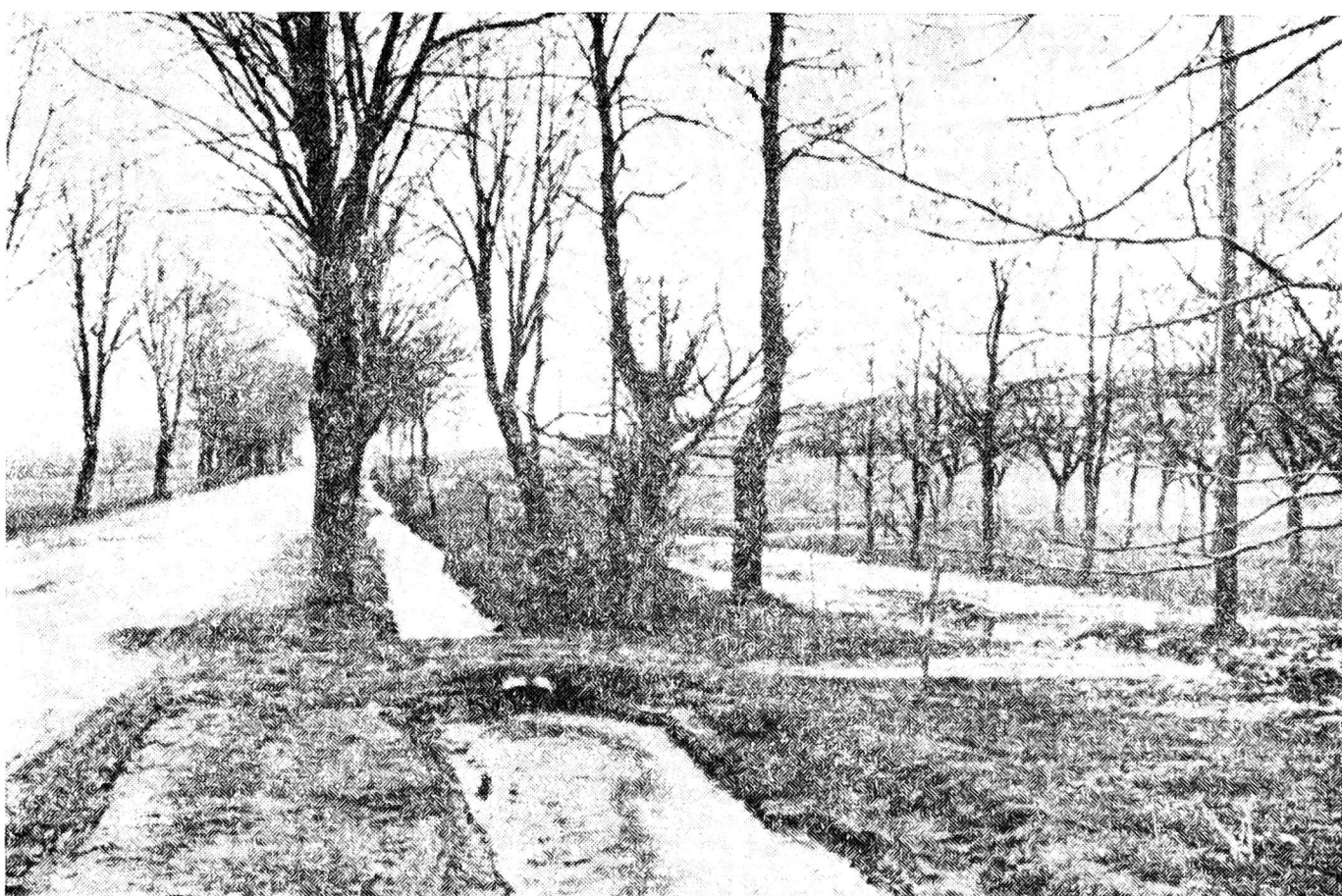
Rys. 10. Zamulone rowy przydrożne i przepusty
