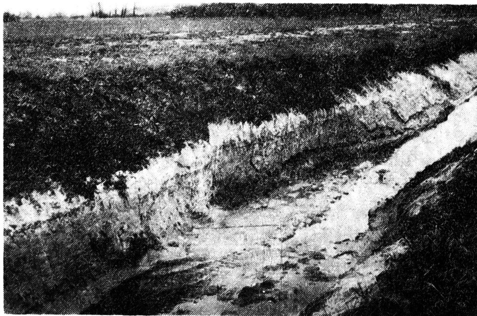
Fot. 1. Zniszczone skarpy rowu nieubezpieczonego Фот. 1. Разрушение откоса неукрепленной канавы Phot. 1. Destruction of slopes of an unprotected ditch
