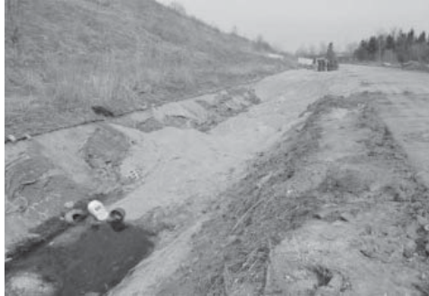
RYSUNEK 4. Budowa drenażu opaskowego odcieków w miejscu rowu, 2012 rok FIGURE 4. Construction of leachate drainage Instead of leachate ditch, 2012
