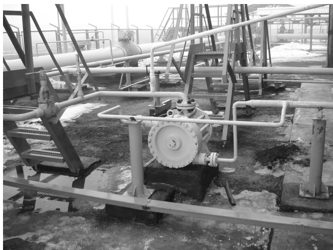
Рис. 3. Установка ДГУ-8-380-Т-У1 на "АГРС-5 Волгоград"
