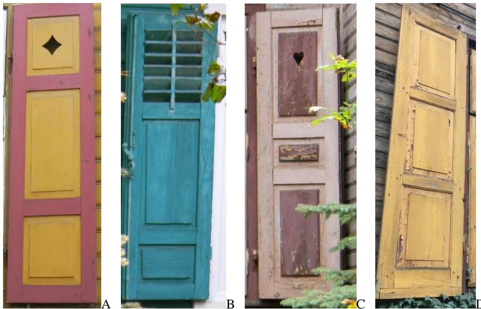
Figure 15. Triple recess shutters: A- Kołataja 29 (No.16), B- Sucha 7 (No.72), C- Majowa 24 (No.36), D- Świerkowa 16 (No.73).
