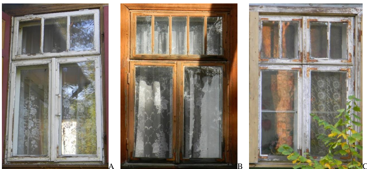
Figure 3. Windows with muntins above the transom A- Kołłątaja 29 (No.16), Kościuszki 7 (No.24), Słoneczna 8 (No.69)
