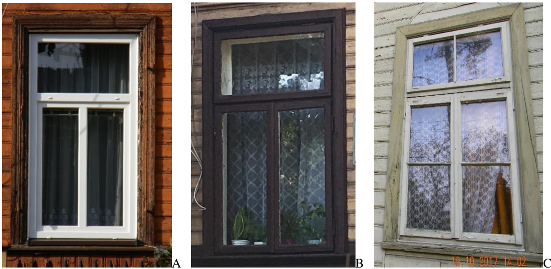
Figure 14. Batten frames around windows: A- Kościelna 23 (No.22), B- Narutowicza 51 (No.55), C- (38) Mała 3 (No.38)
