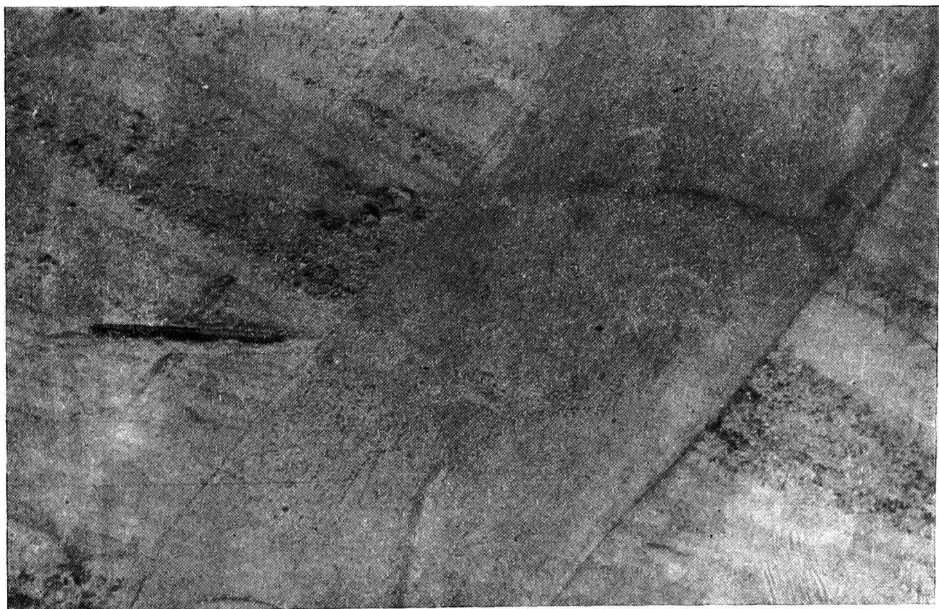
Fot. 4. Odsłonięcie nr 1. Zbliżenie części środkowej. Widać wyraźnie materiał wypełniający szczelinę; widoczna pęknięta soczewka żwiru, rozsunięta na szerokość szczeliny
