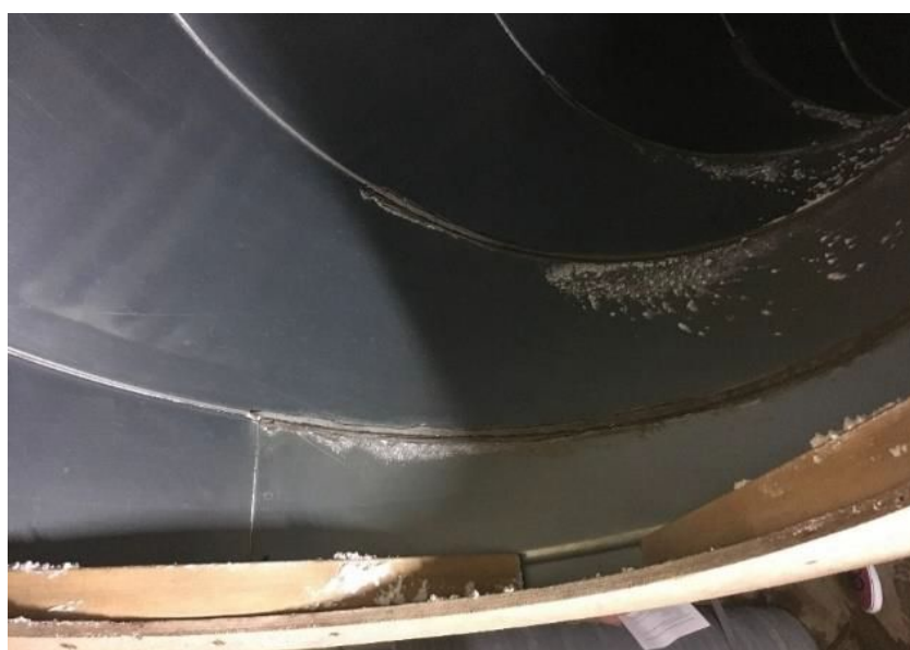
Fot. 4 i 5. Krytycznym miejscem w przechowalniach o składowaniu w paletach skrzyniowych, w największym stopniu zanieczyszczonym chloroproflamem, jest system wentylacyjny (foto: PVC)
