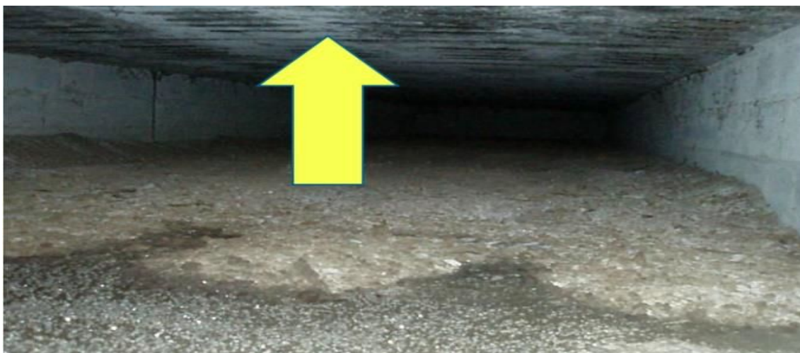
Fot. 3. Kanał wentylacyjny podziemny z osypaną ziemią i złogami chloroproflamu (foto: PVC)
