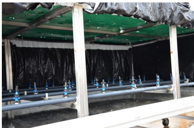
Fot. 3. Zaciemniona część komory aeroponicznej. Widoczne otwory w blacie i dysze zamgławiające (fot. B. Wasilewska-Nascimento)
