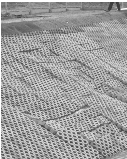
Rys. 6. Przykład zniszczeń (awarii) ścian zbiornika: a – wschodniej, b – południowej
