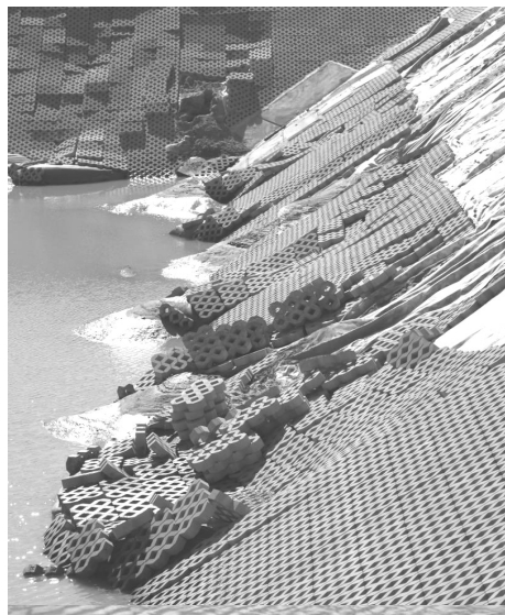
Rys. 6. Przykład zniszczeń (awarii) ścian zbiornika: a – wschodniej, b – południowej
