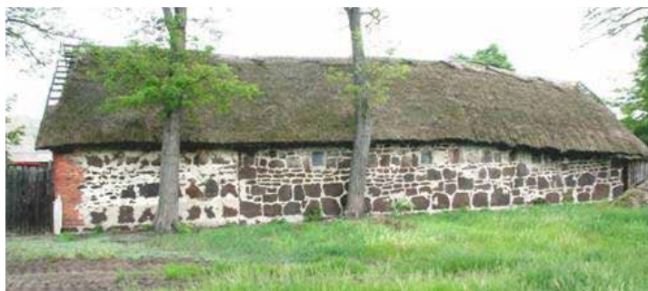
Ryc. 3. Budynek gospodarczy z rudy darniowej („dom z żelaza”) w Czarnymbrodzie (fot. P. Anders) Fig. 3. Farm building made of bog ore (“house of steel”) in Czarnybród
