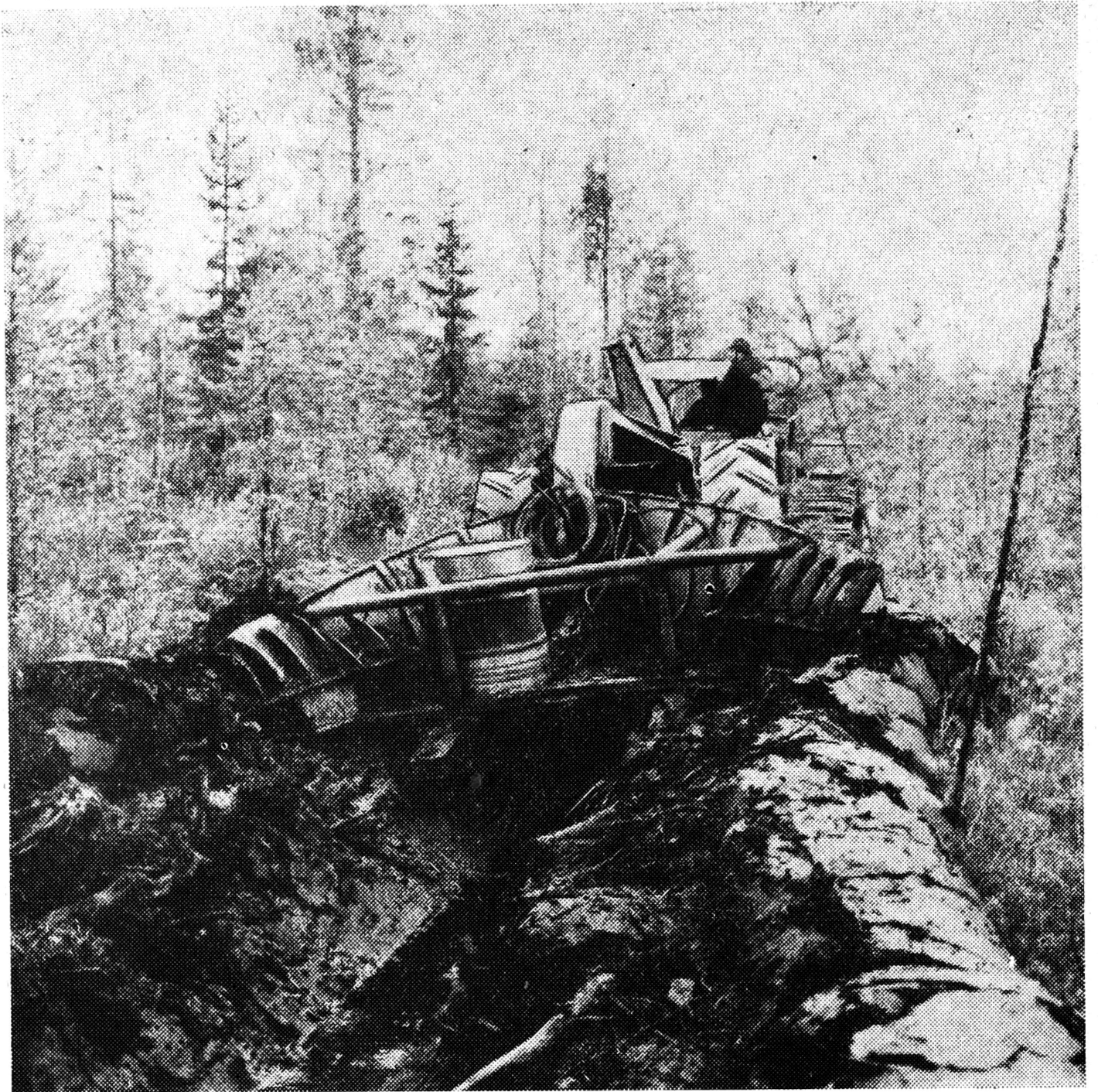
Fot. 3. Wyorywanie rowu melioracyjnego na torfowisku za pomocą pługa „Lokomo”
