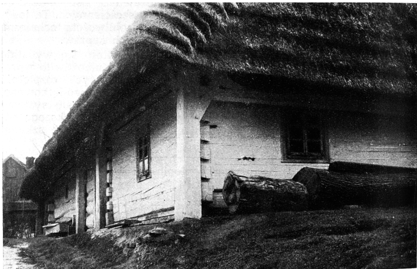
Ryc. 3. Markowa, pow. Przeworsk. Mieszana konstrukcja zrębu ściany — wieńcowo-słupowa. Fot. I. Tłoczek
