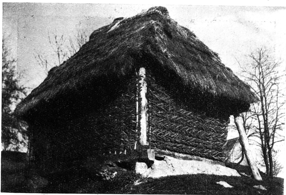
Ryc. 1. Skurowa, pow. Jasło. Kosznica wiklinowa, rok budowy 1910 Fot. I. Tłoczek
