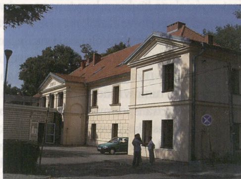
Ryc. 1. Łazienki „Zofia” w Krzeszowicach. Fot. M. Golas
