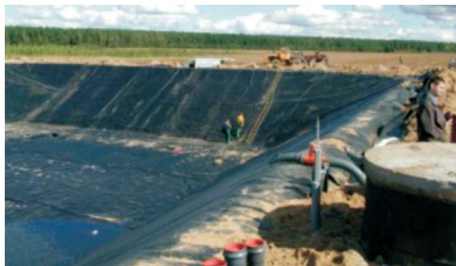
Rys. 1. Budowa laguny na gnojowicę [8]
