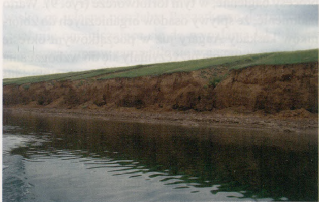
Ryc. 6. Aktywizacja procesów erozyjnych na wybrzeżu Zbiornika Brackiego. Fot. V. Khak.
