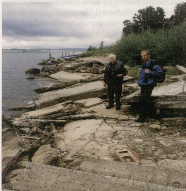
Ryc. 3. Zniszczone żelbetowe umocnienia brzegów Zbiornika Irkuckiego. Fot. M. Rzętała.
