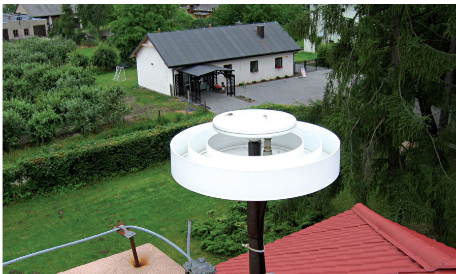
Ryc. 3. Stacja referencyjna firmy Ashtec na dachu budynku CEPL w Rogowie (fot. M. Brach) Fig. 3. Ashtec reference station on the CEPL buidling in Rogow
